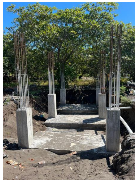
MEJORAMIENTO SISTEMA DE AGUA POTABLE ALDEA EL CEBOLLITO, CHIQUIMULILLA, SANTA ROSA.
