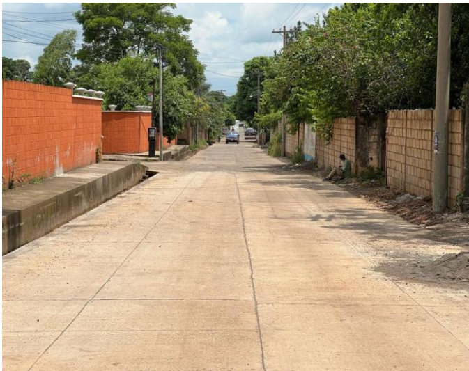
MEJORAMIENTO CAMINO RURAL INGRESO ALDEA EL UJXTAL, CHIQUIMULILLA, SANTA ROSA
