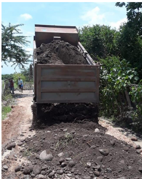
CONSERVACION Y MANTENIMIENTO CAMINOS DEL SECTOR RURAL, ALDEAS Y CASERIOS PIEDRA ROJA, LAS BRISAS, SAN ANTONITO Y EL SANATE, CHIQUIMULILLA, SANTA ROSA
