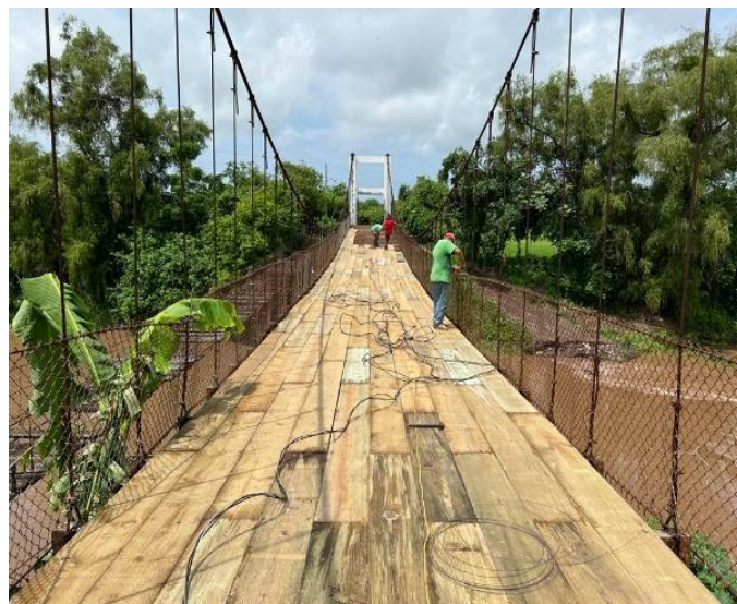
MEJORAMIENTO PUENTE COLGANTE PEATONAL (HAMACA) CASERIO MATAMOROS, CHIQUIMULILLA, SANTA ROSA
