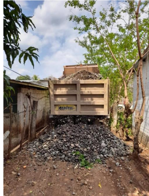
CONSERVACION Y MANTENIMIENTO DE CAMINOS DEL SECTOR RURAL, ALDEA LA FAJA, CHIQUIMULILLA, SANTA ROSA
