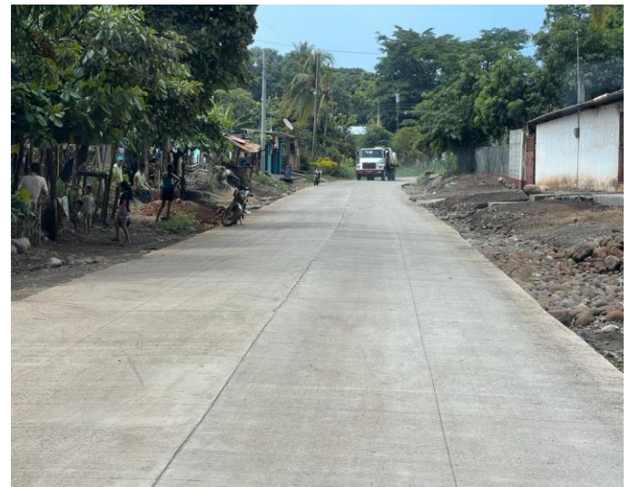
MEJORAMIENTO CAMINO RURAL ALDEA EL OBRAJE CENTRO, CHIQUIMULILLA, SANTA ROSA
