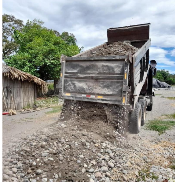
CONSERVACION Y MANTENIMIENTO DE CAMINOS DEL SECTOR RURAL, ALDEA EL AHUMADO, CHIQUIMULILLA, SANTA ROSA
