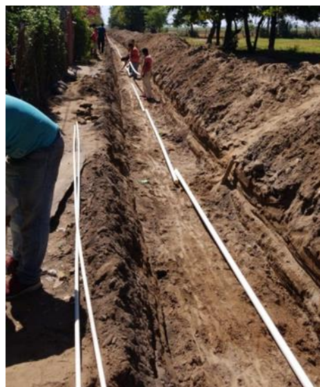
MEJORAMIENTO SISTEMA DE AGUA POTABLE EL MILAGRO LOS CERRITOS, CHIQUIMULILLA, SANTA ROSA (instalación tubería)
