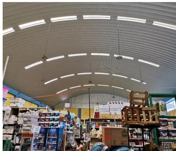
MEJORAMIENTO MERCADO NO. 2, BARRIO SANTIAGO CHIQUMULILLA, SANTA ROSA
