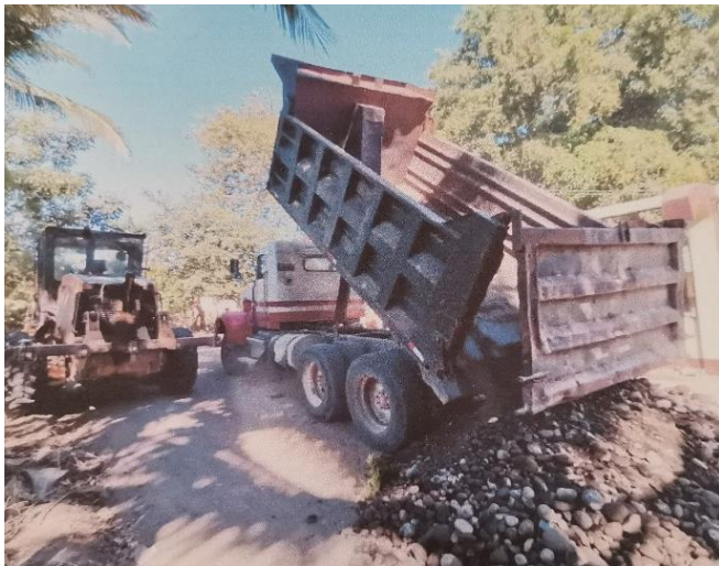
CONSERVACION Y MANTENIMIENTO DE CAMINOS DEL SECTOR RURAL, LAS PALMITAS, CASERIO SANTA ROSA, CHIQUIMULILLA, SANTA ROSA
