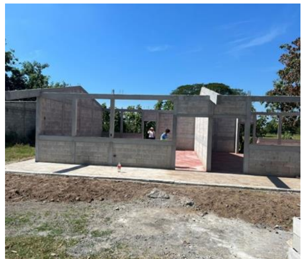
CONSTRUCCION ESCUELA PREPRIMARIA CASERIO LAS POZAS, CHIQUIMULILLA, SANTA ROSA
